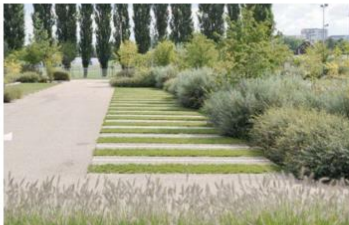
Exemple d'aménagement perméable avec bande de roulement
